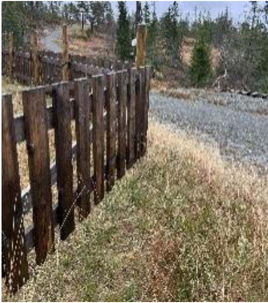
Bilde 5. Enkelt stakittgjerde
