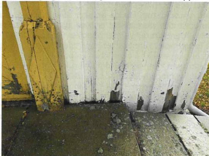
Skader ved inngangsparti. Bordkledning og deler av portal.
