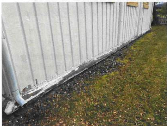
Skader i maling samt råteskade på vannbrett. Sørvegg.
