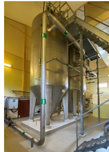
Figur 10: Sandfiltre ved Jamtåsen vannbehandlingsanlegg [Foto: Meråker kommune]
