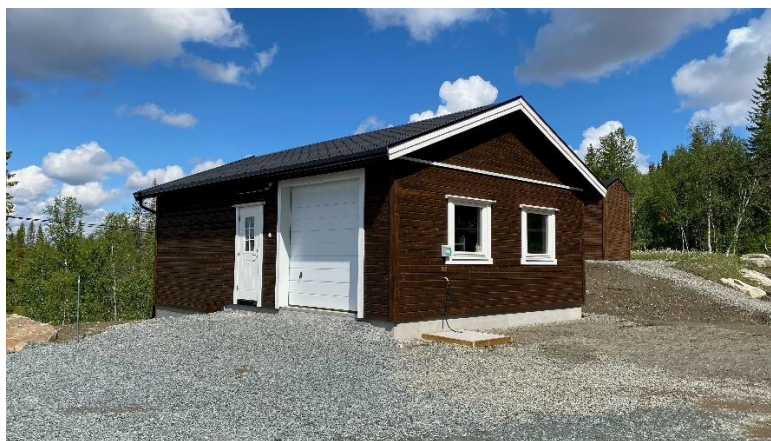
Figur 18: Tevellia vannverk [Foto: Meråker kommune]
