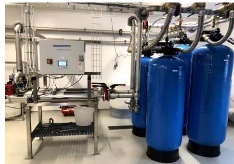
Figur 19 Tevellia vannbehandlingsanlegg (Foto: Meråker kommune)
