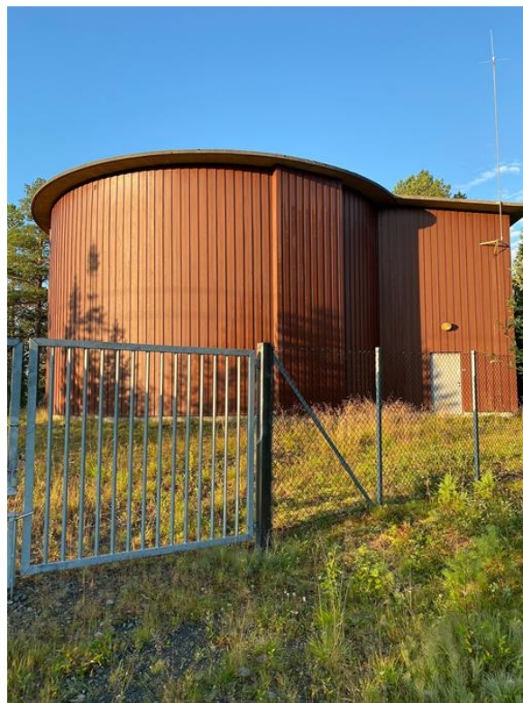
Figur 34: Thune drikkevannbasseng [Foto: Meråker kommune]
