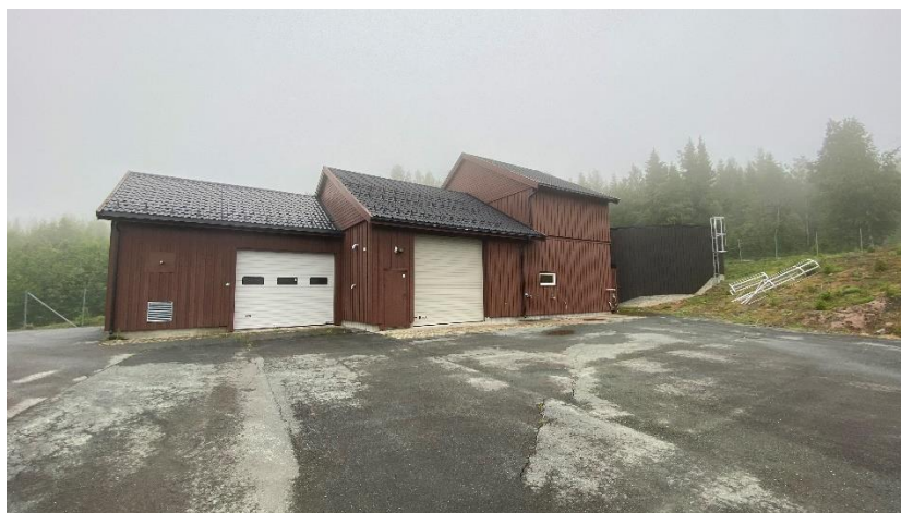
Figur 8: Jamtåsen vannbehandlingsanlegg [Foto: Meråker kommune]
