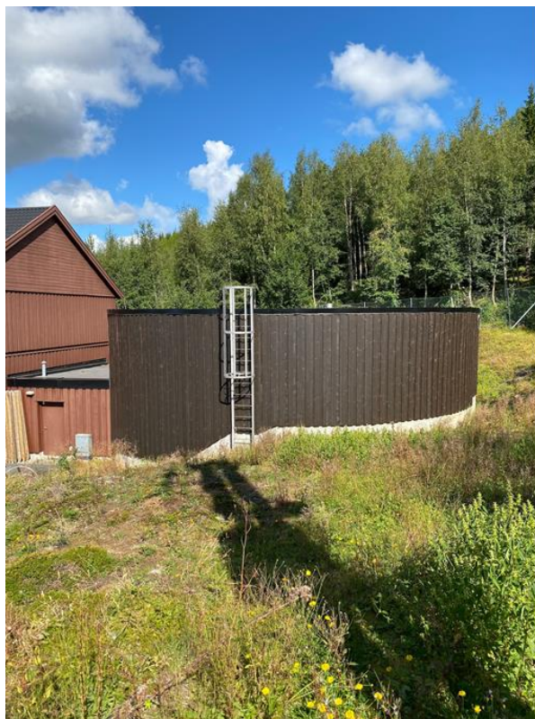
Figur 12: Jamtåsen vannrenseanlegg, drikkevannsbasseng [Foto: Meråker kommune]
