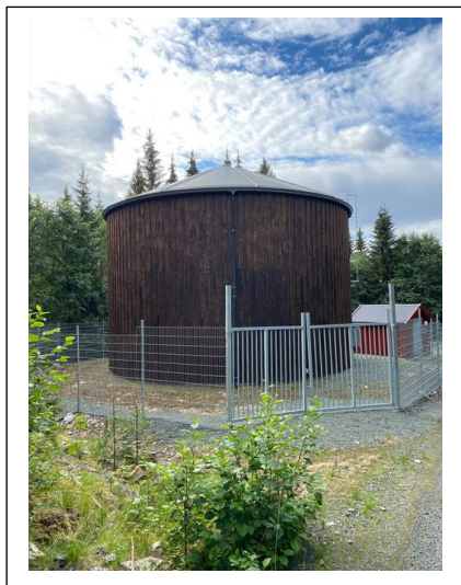
Figur 17: Grandalsmoen drikkevannsbasseng [Foto: Meråker kommune]
