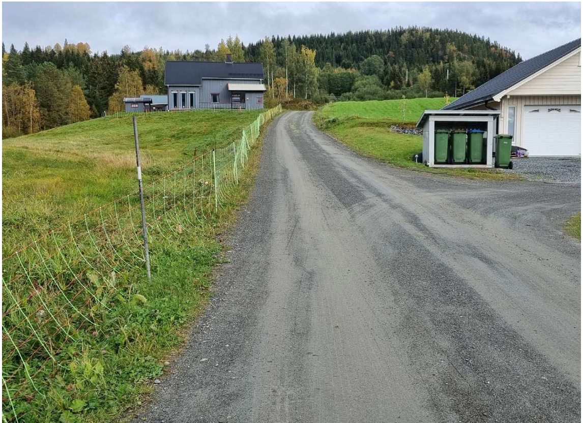
Figur 13: Bildet viser gjerde som er plassert helt inntil Klokkehaugveien, og som derfor har blitt utsatt for skader. Veistikke er blitt satt ut rundt 25 cm fra veikant, som er et minimum for å få plass til brøytebil.
