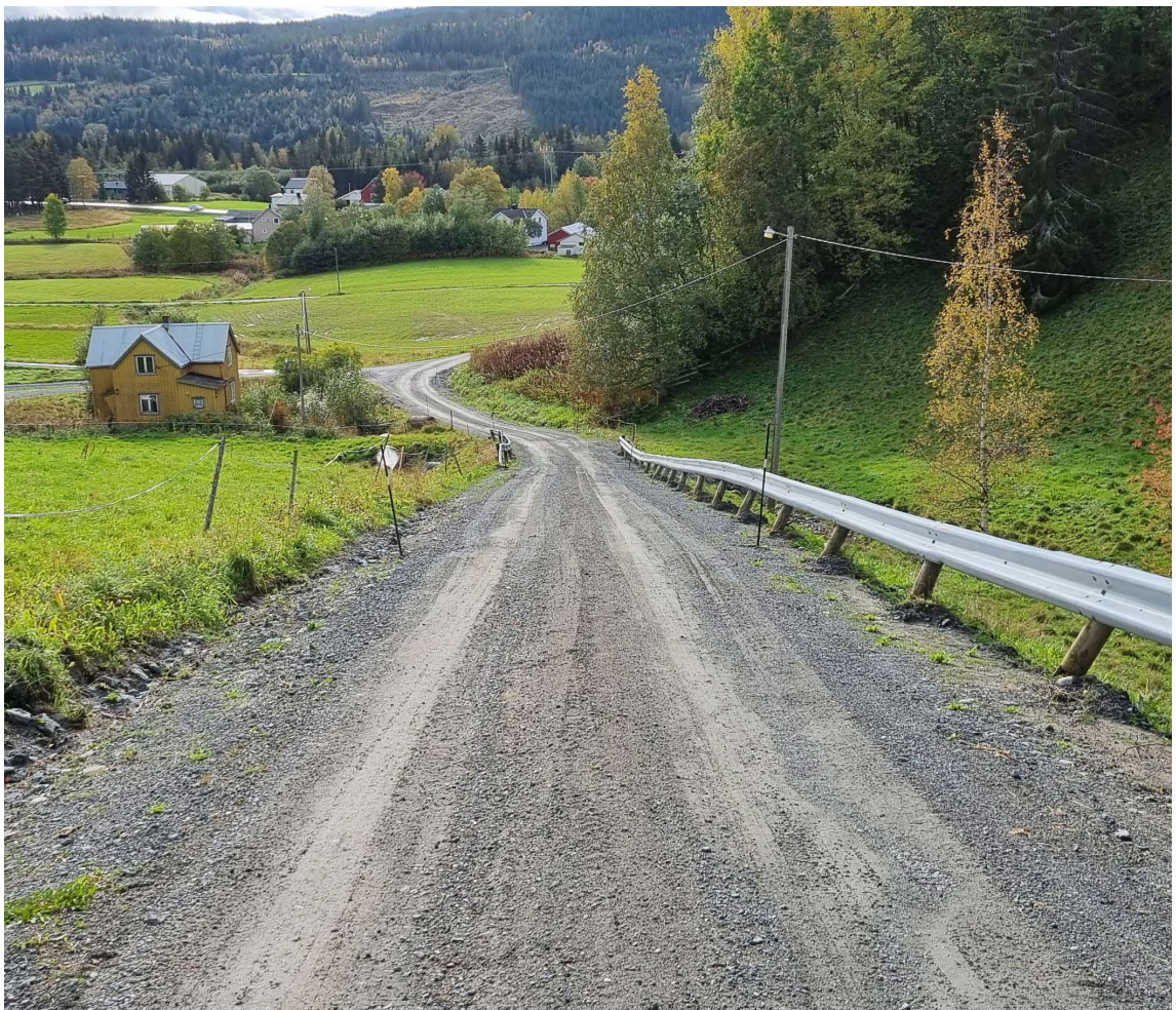
Figur 2: Aunveien er en kommunal vei som går til en husstand. Veien har en stigning på nedsiden av jernbaneundergangen på 19,2% og på oversiden en stigning på 14,2%.
