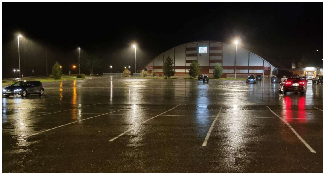
Figur 16: Trafiksikkerhetstiltaket utbygging av gatelys ved parkeringsplass for Meråker videregående skole er nå gjennomført med støtte fra Statens vegvesen. Lysene ble påkoblet 23.09.24 (foto Meråker kommune). Gatelys i Skolgata med støtte fra Trøndelag Fylkeskommune ble også ferdigstilt høsten 2024.
