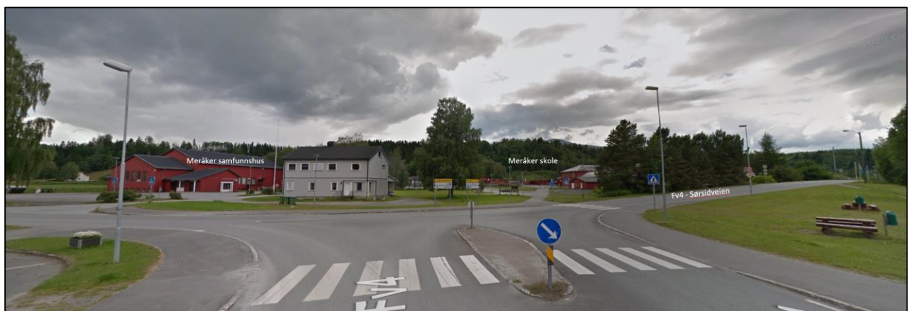
Figur 3-3: Foto fra området med standpunkt i krysset Sørsidveien – Torsbjørkveien (kilde: Google gatebilder).
